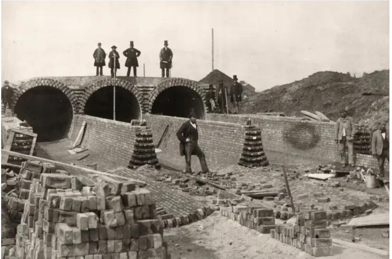
Joseph Bazalgette supervisa las obras del colector del norte, justo debajo de la estación de bombeo de Abbey Mills, en el este de Londres, durante la construcción del gran sistema de alcantarillado victoriano. Foto: Wikimedia
