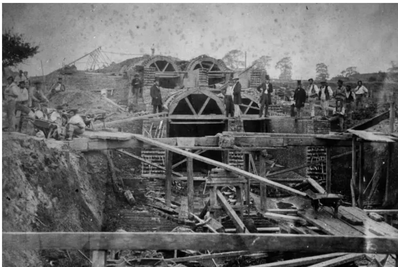
En 1862, obreros británicos trabajan en la construcción del colector principal del norte y su desagüe hacia el río Lea, parte clave del ambicioso plan para sanear Londres. Foto: Otto Herschan
